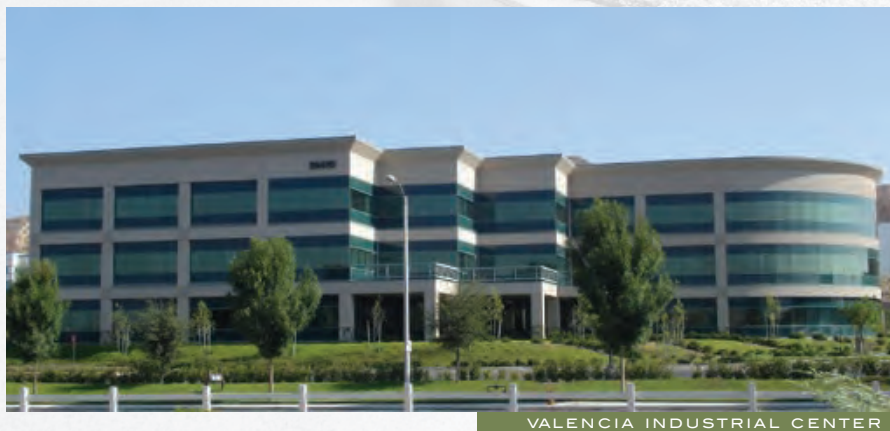
VALENCIA INDUSTRIAL CENTER
